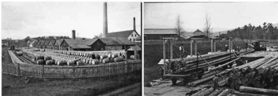
Sklad sudů a pila
