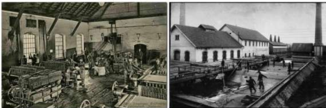
Pohled na vnitřní zařízení – lisovna a plavení tuhy
